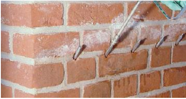
5. att. PUR injekcijas sveču injekcija.
