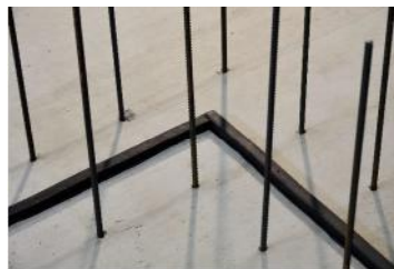
Nostiprināšana ar uzbriestošās lentas līmi
