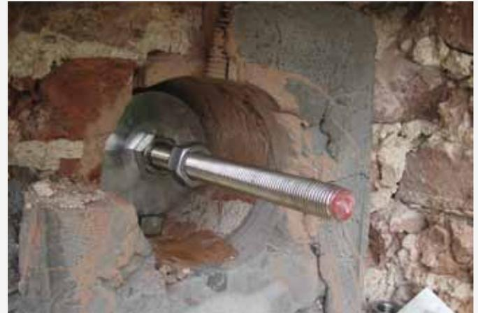
Einbaubeispiel des Spannkraftreglers/Installation example of the load control unit
