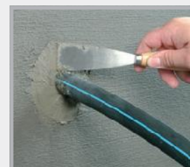
Aizdare ar ātri cietējošu cementu
